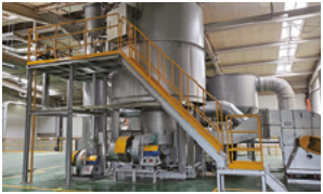
▲ 바이오연료 제조공정 신규 방지시설 설치
